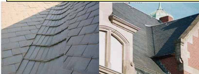
Bildoj 1 & 2: malsamaj metodoj sur la tegmento de la stacidomo de Colmar: maldekstre ĝermana metodo. Dekstre franca metodo.
